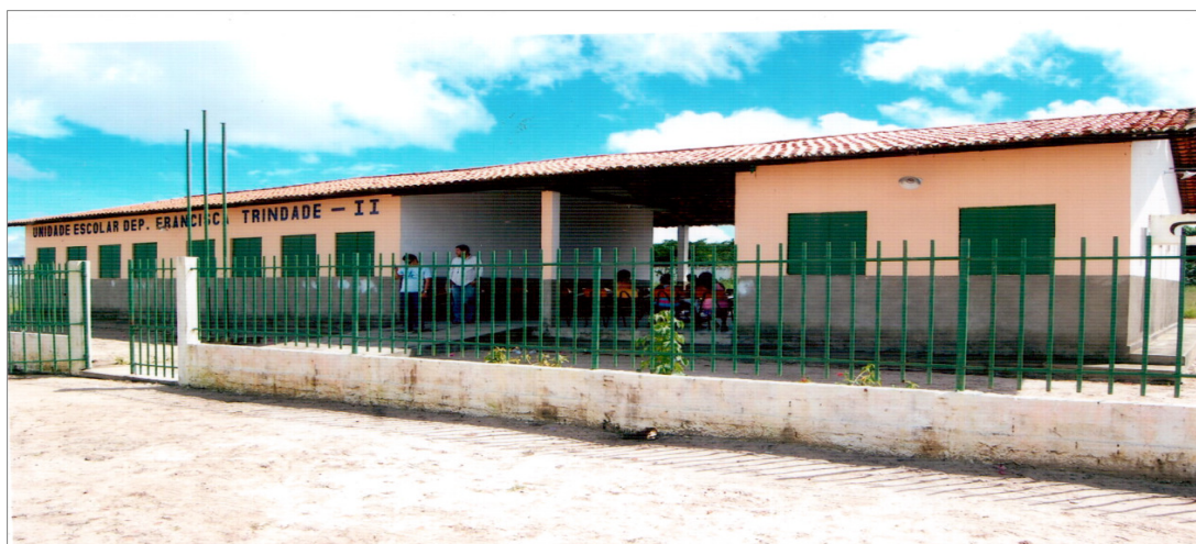
FIGURA 09 – UNIDADE ESCOLAR DEP. FRANCISCA TRINDADE II
